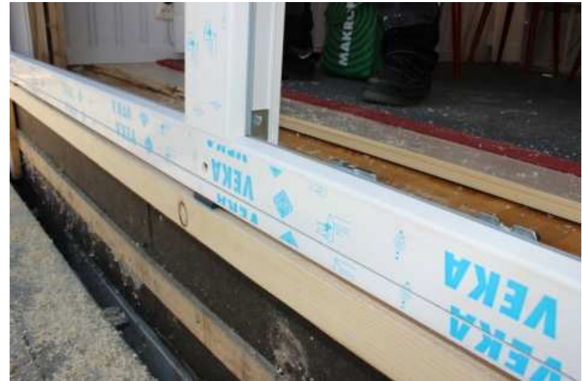
Spår för fönsterbleck
