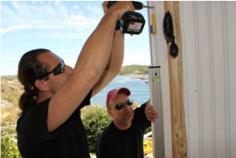
Håll 8 mm med metall borrh
