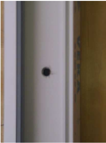
Håll 8 mm med metall borrh
